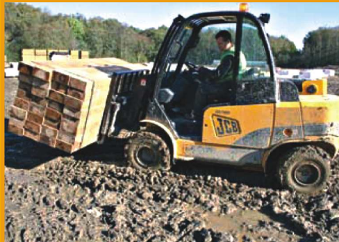
惡劣地形作業
